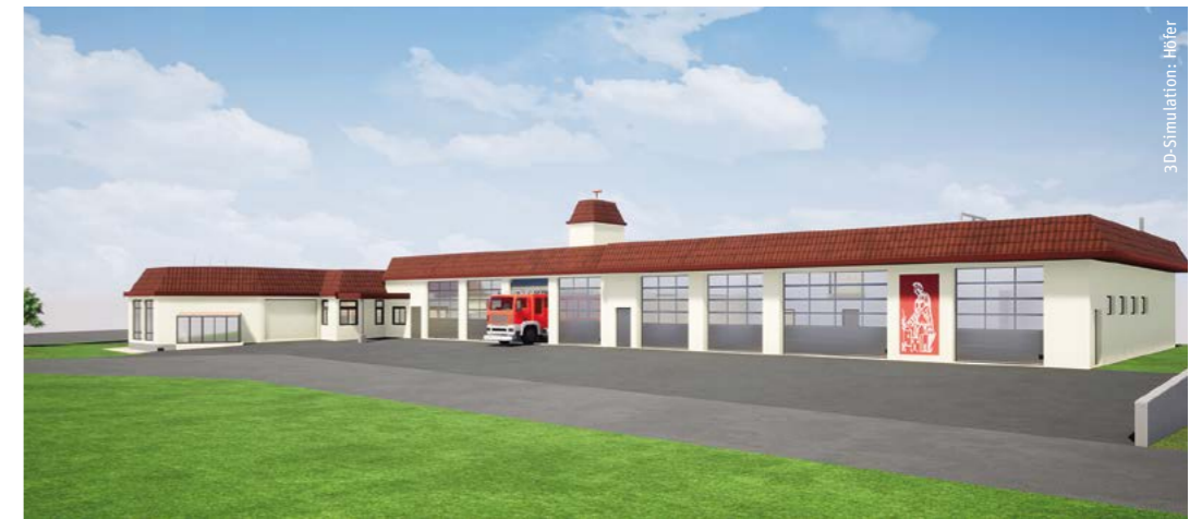
Veränderungen im Außen- und Innenbereich für eine moderne und einsatzbereite Feuerwehr in Laxenburg
