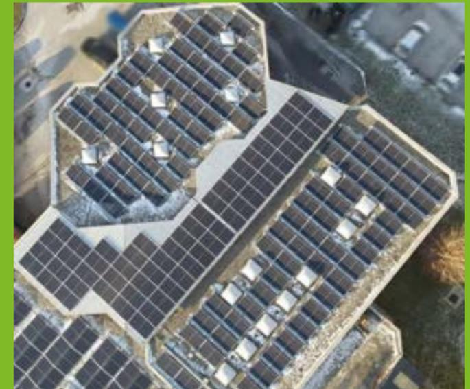
Das Institut für angewandte Systemanalyse (IIASA) hat sich kürzlich mit Voltaigo, einem lokalen Photovoltaik-Anbieter zusammengetan, um ein 220-kWp-System mit fast 500 PV-Paneelen zu realisieren. Nach Abschluss der Bauarbeiten soll sich die Investition in den nächsten zehn Jahren finanziell auszahlen. Diese Initiative bietet nicht nur die Möglichkeit, den Treibhausgasausstoß des Instituts erheblich zu verringern, sondern auch ein wirtschaftliches Energieeinsparungspotenzial.
