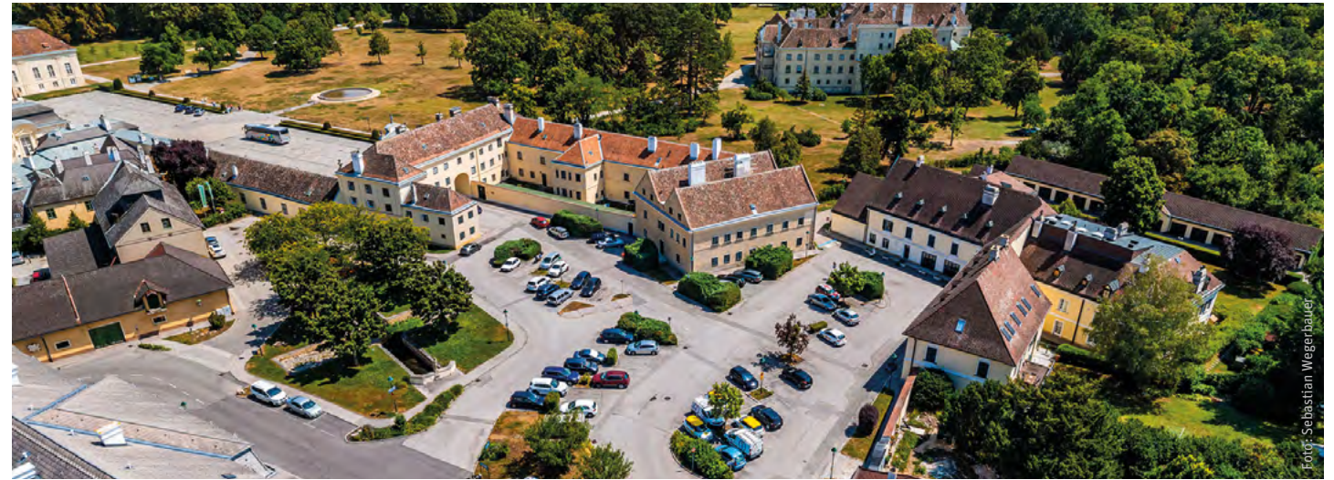
Gerüstet für den nächsten Sommer: Der Beginn der umfangreichen Bauarbeiten am Johannesplatz wird noch in diesem Frühling sein.
